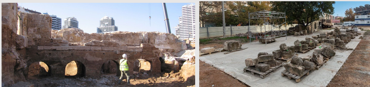
Cárcavas. Estado original y actual.
